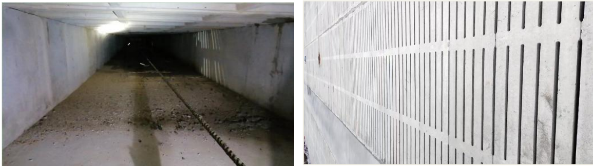
图 2.2-4 粪道、漏缝地板参考图
