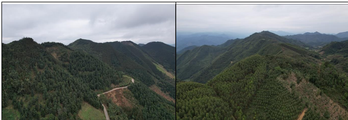
图3.1-1 风电场场址地形地貌
