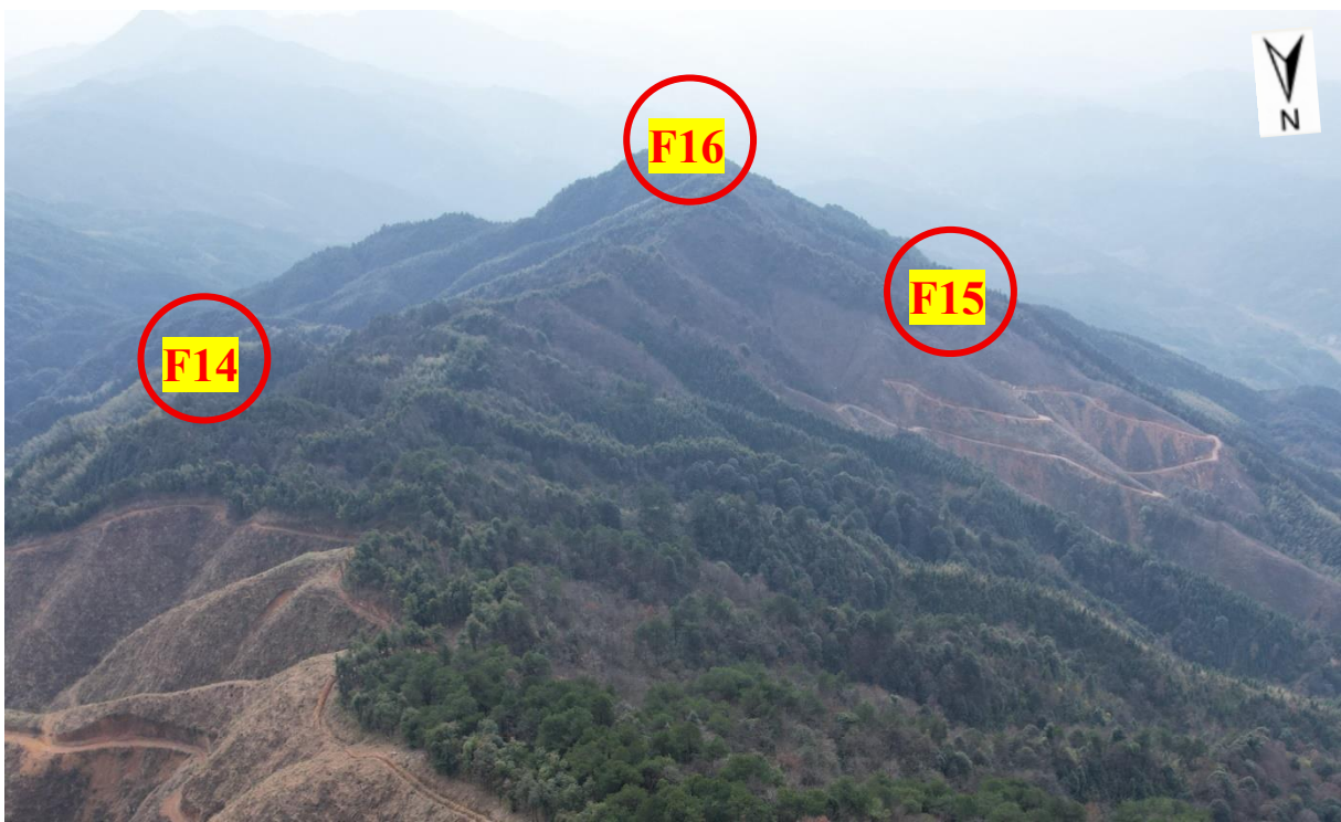
F01~F16 风机区域现状航拍（2025 年 12 月 25 日）
