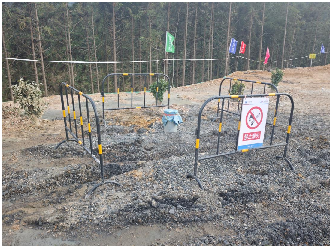
图2.6-3 升压站内取水口现状图
