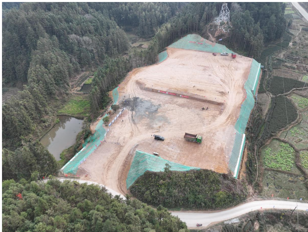
升压站施工现状（2025年12月31日）
