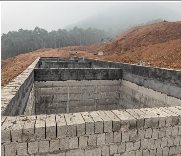
项目现场情况（已建集污池）
