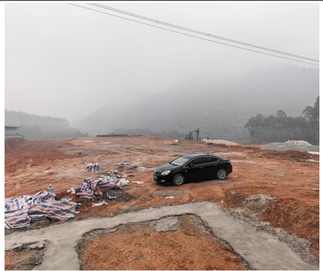
项目现场情况（待建 2 栋猪舍现状）
