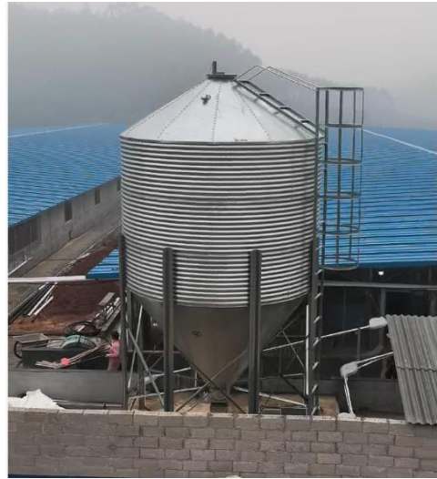
项目现场情况（已建 2 栋猪舍）
