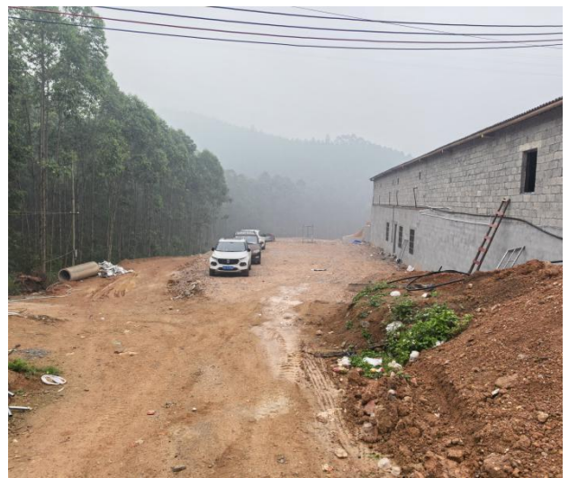
项目现场情况（东侧场界及生活区）
