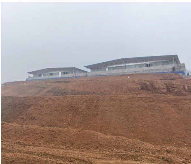
项目现场情况（已建 2 栋猪舍及场地北侧现状）
