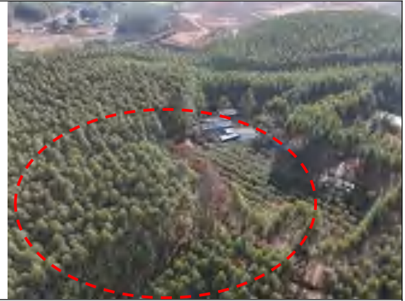
拟建变电站站址东部现状
