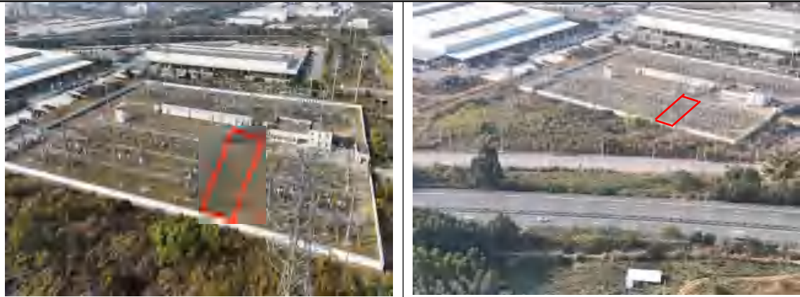
图 2-1 220kV 双仁变电站间隔扩建侧现状照片
