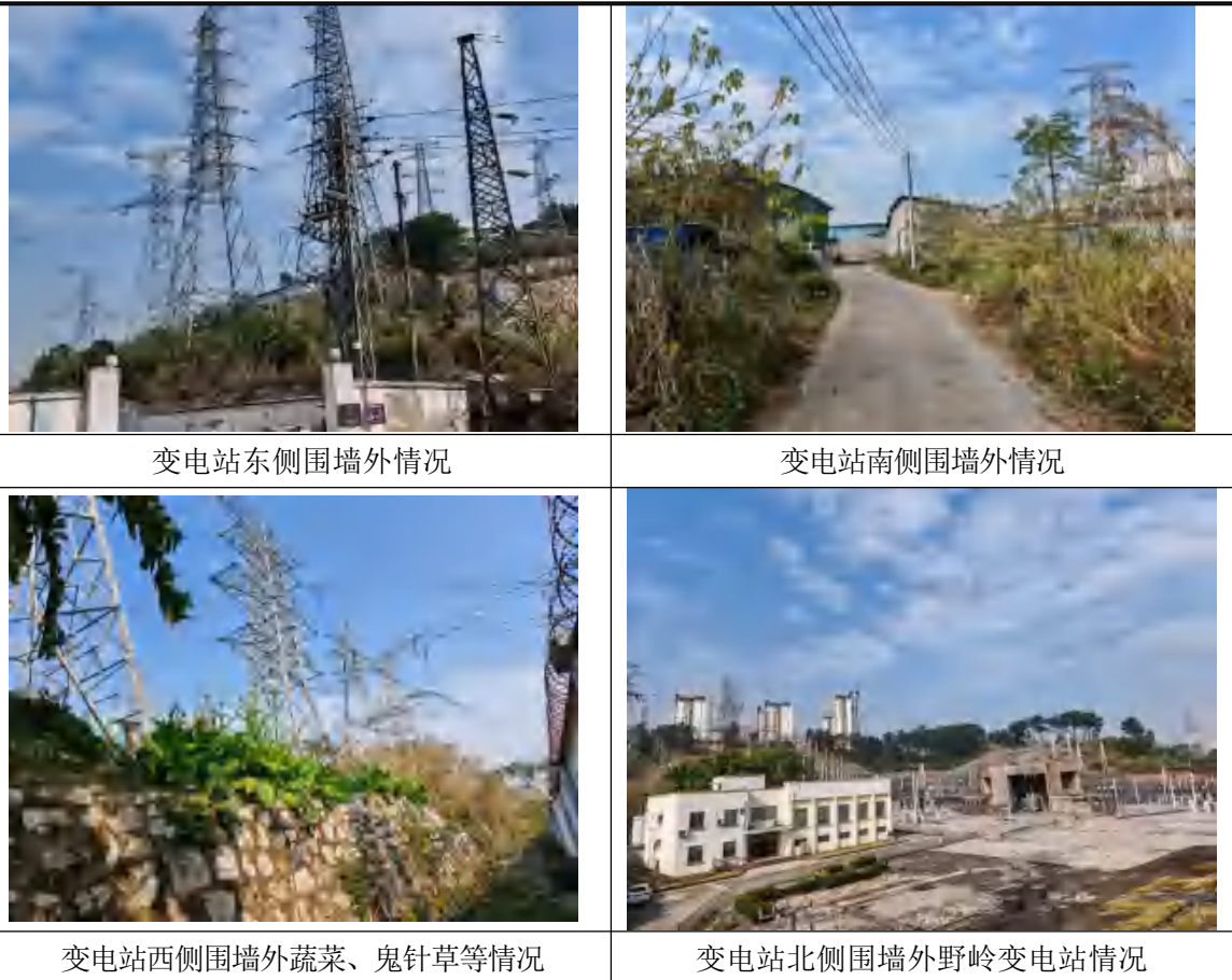
图 3-1 本项目变电站周边及站内植被情况
