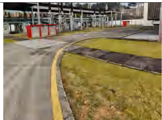
变电站站内道路硬化及植被绿化（马尼拉草）
