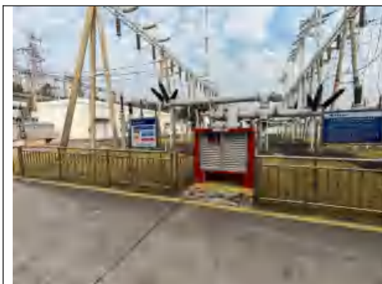
变电站 110kV 配电装置区绿化（马尼拉草）
