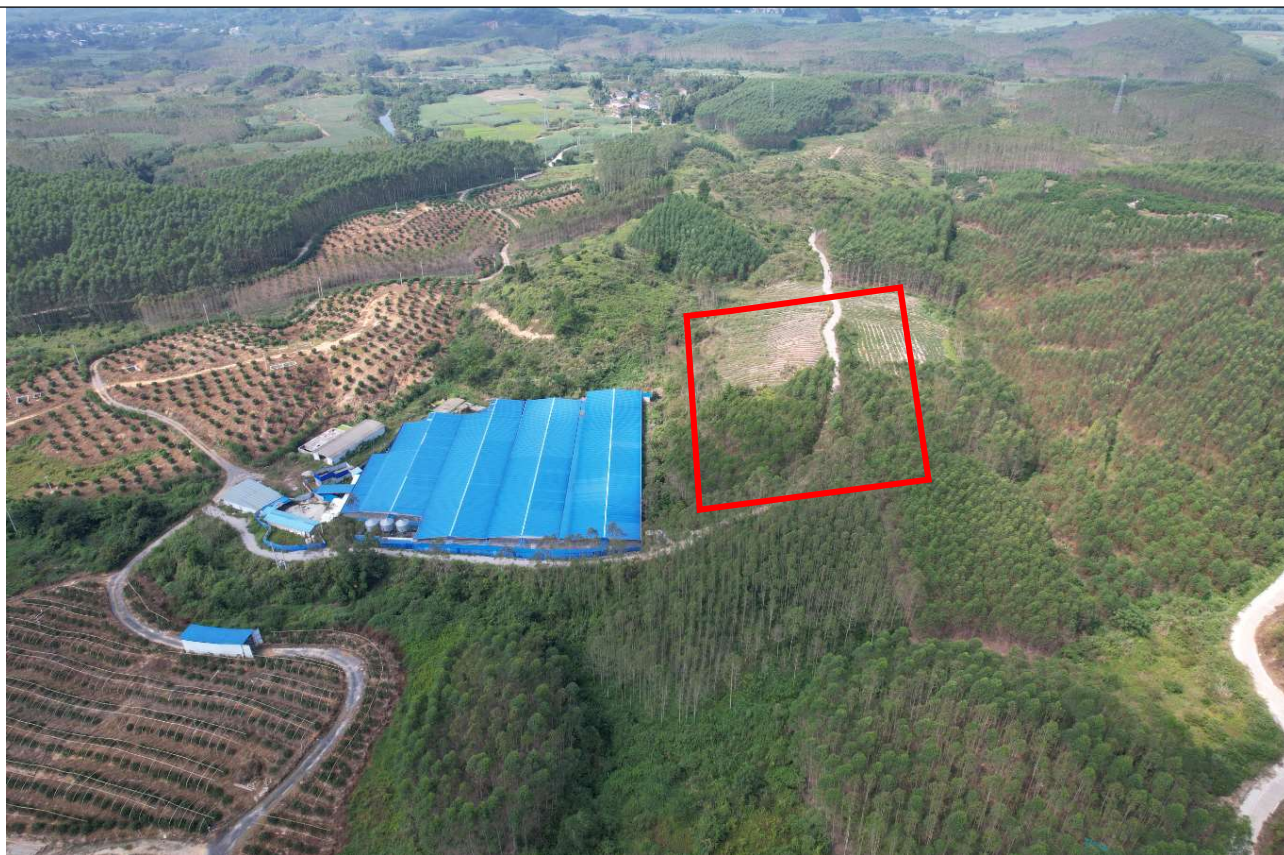
融水荣山光伏升压站站址
